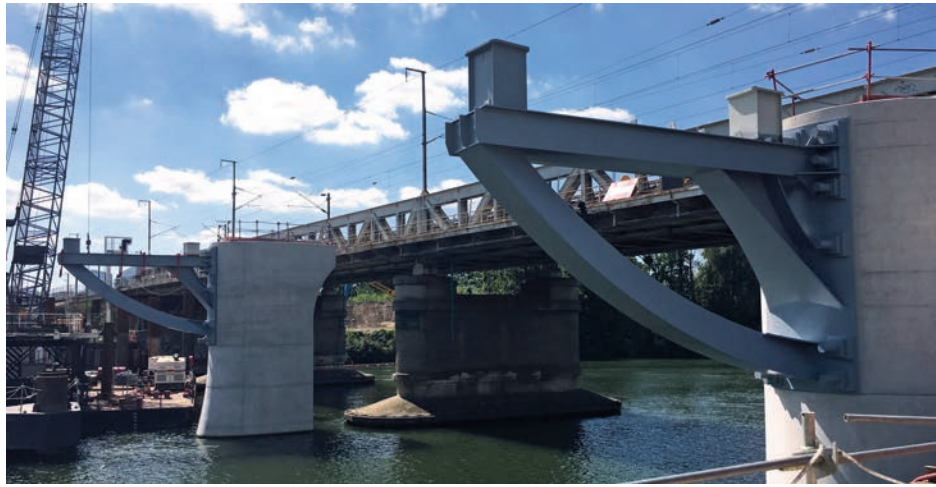
Adossée au chantier de prolongement du RER E, la passerelle, réservée aux circulations douces et enjambant la Seine entre Nanterre (Hauts-de-Seine) et Bezons, commence à prendre forme.
